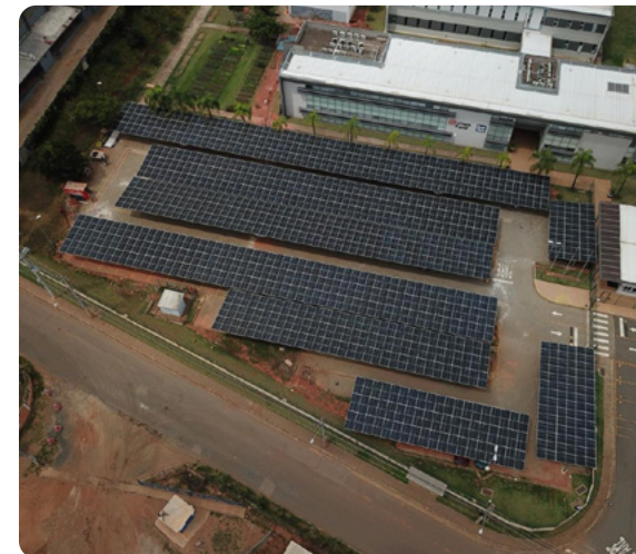
A unidade fotovoltaica ocupa uma área total de 2.332,9 m 2 (cerca de 25.000 pés) e tem capacidade para produzir aproximadamente 450 kWp de potência.
