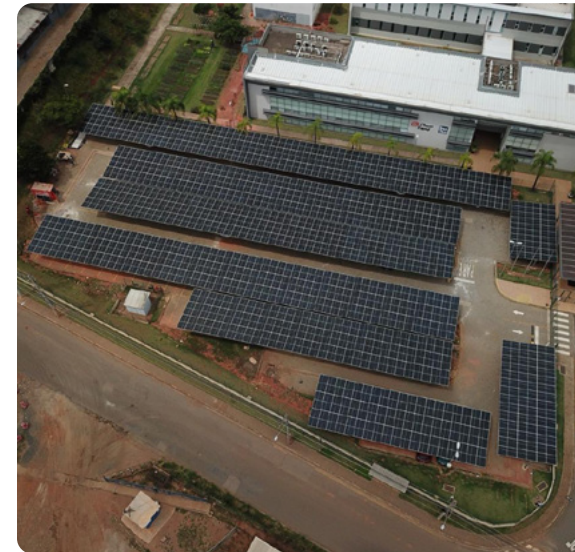
Die Photovoltaikanlage nimmt eine Gesamtfläche von 2.332,9 m 2 (ca. 25.000 ft 2 ) ein und hat eine Leistungskapazität von ca. 450 kWp.
